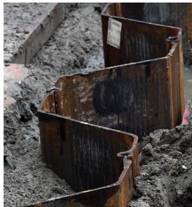
Damwandplanken in de grond
